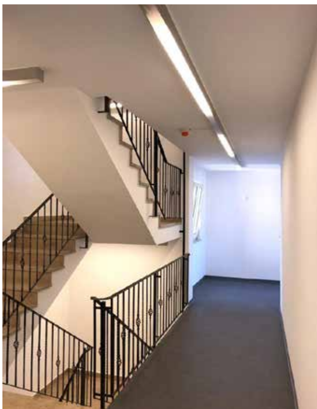
Das Treppenhaus nach Durchführung der Maßnahme, hell und freundlich mit automatischer Lichtsteuerung.
