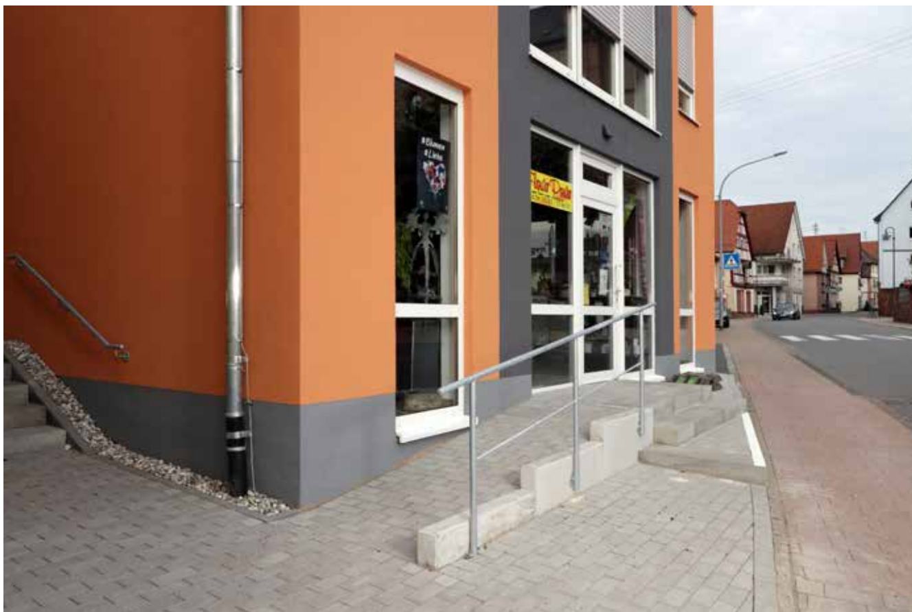
Das Ladengeschäft ist nach der Modernisierung über eine gut begehbare Treppe sowie eine Rampe für Rollstuhl- und Rollatoren-Nutzer erreichbar.
