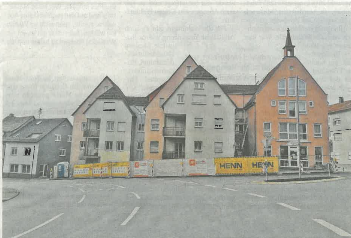
Das Mehrfamilienhaus an der „Wertheimer Straße“ in Hardheim soll schon bald in neuem Glanz erstrahlen.
