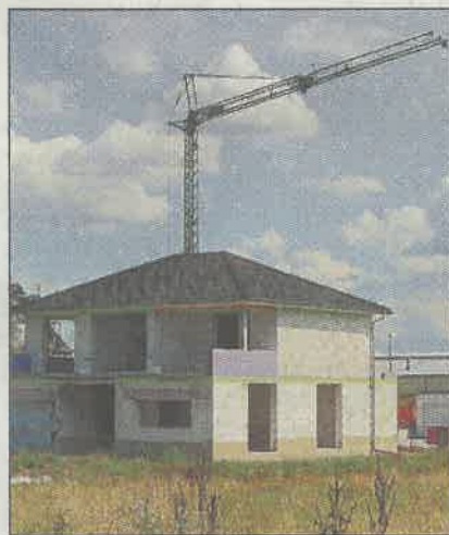
Wie hier in Waldürn wird im Altkreis Buchen fleißig gebaut. Foto: Rüdiger Busch
