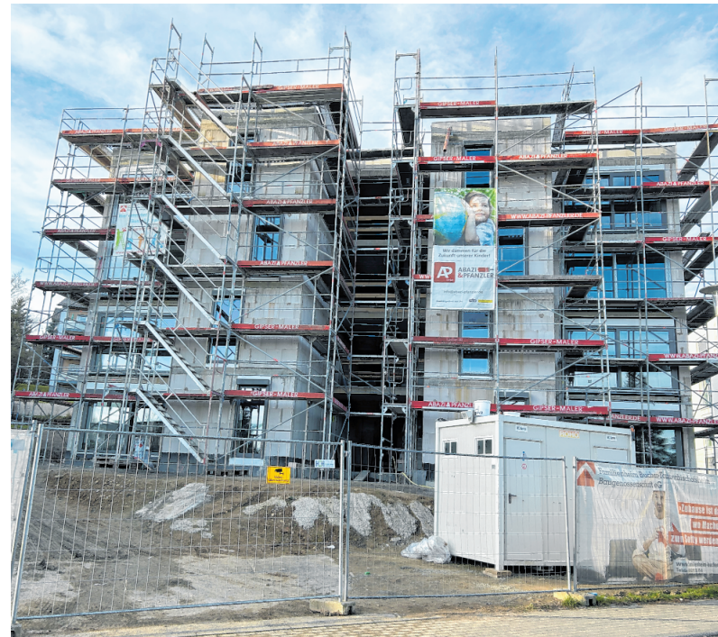
Das aktuelle Bauvorhaben der Baugenossenschaft in der Buchener Bgm.-Vinzenz-Kieser-Straße.
