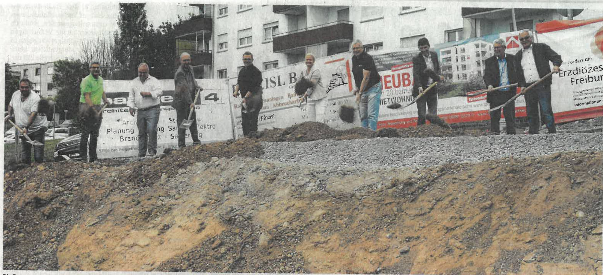
Die Baugenossenschaft Familienheim Buchen-Tauberbischofsheim baut in der Kreisstadt ein Mehrfamilienhaus mit 20 barrierefreien Mietwohnungen. Das Bild zeigt (von links) Bauunternehmer Michael Pfnaisl, Christoph Helter (Technischer Leiter Familienheim), Willi Nadler (Bauwerk4), Markus Günther (Vorstand Familienheim), Bernd Reinhart (Bauwerk4), Bürgermeisterin Anette Schmidt, Thomas Jurgovsky (geschäftsführender Vorstand Familienheim), Gerhard Pfundt (planender Architekt Bauwerk4), Reiner Link, stellvertretender Aufsichtsratsvorsitzender Familienheim und Ekkehard Brand (Aufsichtsratsvorsitzender). BILD: FABIAN GREULICH
